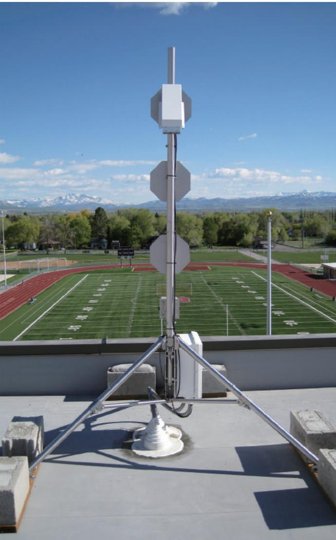
犹他州洛根市的洛根高校中有一套闪电预警系统, 该系统由安装在 10 英尺高的不锈钢三脚架上的 CS110 和闪电指示灯组成, 位于足球场旁边的屋顶上。
