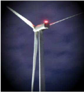
Die bedarfsgerechte Befeuerung wird automatisch von dem Sichtweitensensor gesteuert.
